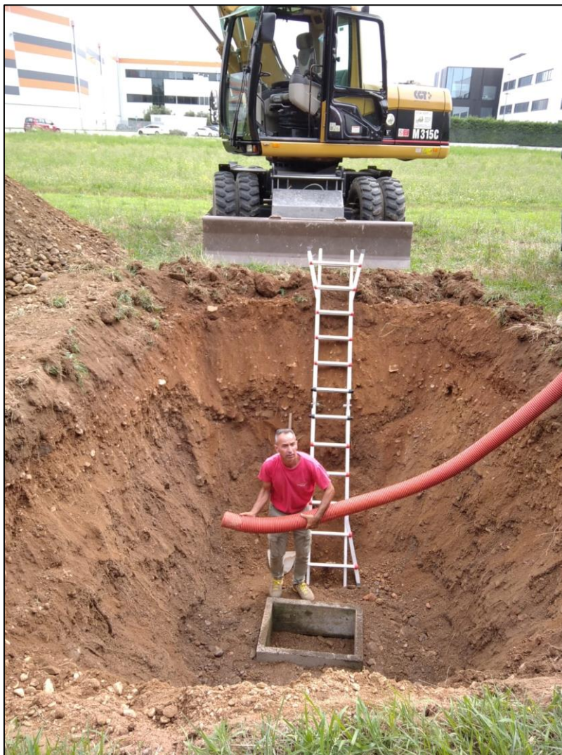
Figura 12 – Predisposizione del pozzetto per la prova a 3.00 m
