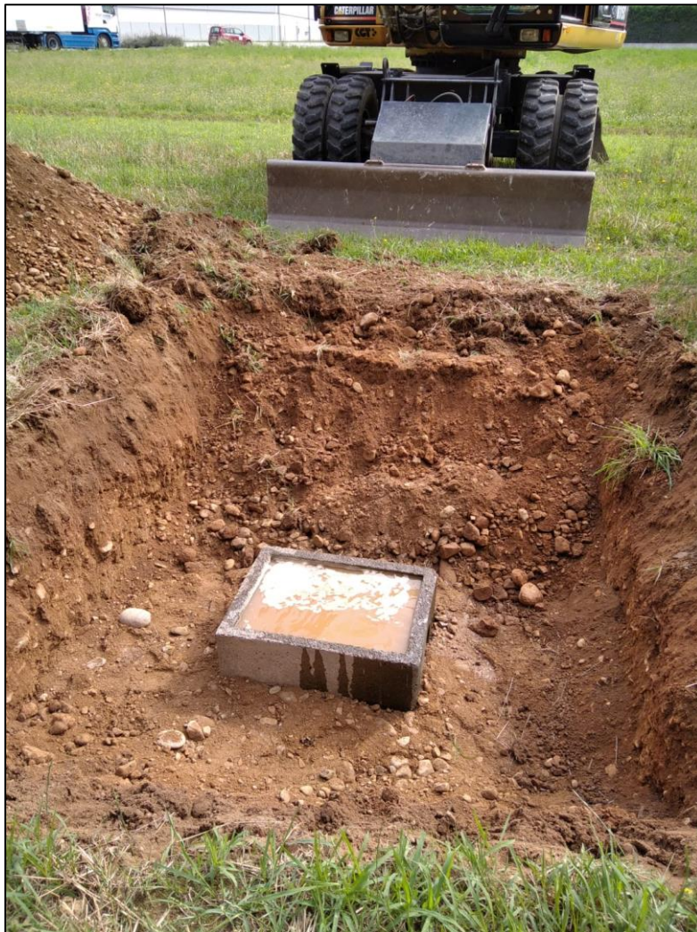
Figura 11 – Esecuzione della prova in pozzetto a 1.50 m di profondità
