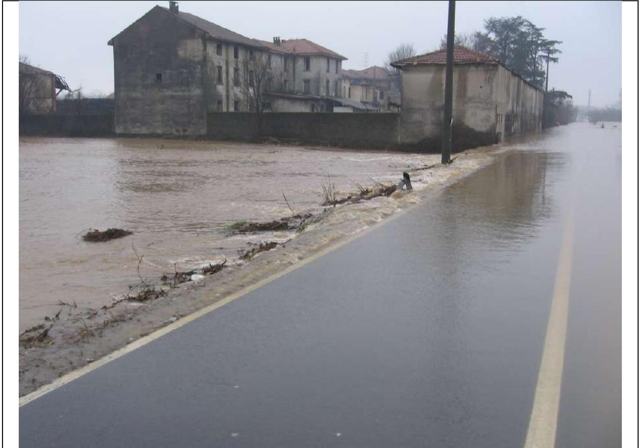
**Fig. 2-4 - allagamenti in seguito alla rotta arginale in SX idraulica del Torrente Bozzente - Febbraio 2009**
