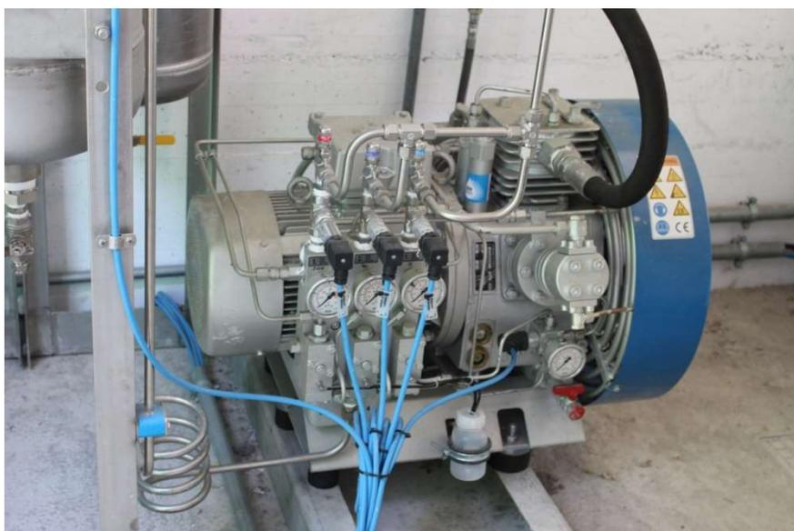
Il compressore di boil-off avrà una portata inferiore ai 20 m<sup>3</sup>/h e rispetterà le indicazioni del Decreto Ministeriale 30 Aprile 2012 "Approvazione della regola tecnica di prevenzione incendi per l'installazione e l'esercizio di apparecchi di erogazione ad uso privato di gas naturale per autotrazione" per le parti inerenti e richiamate dal D.M. di riferimento.
