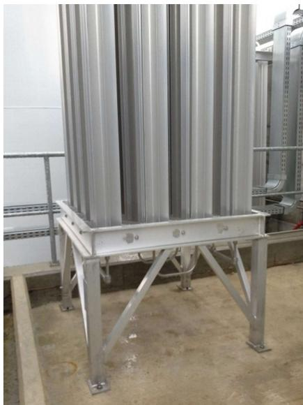
Le dimensioni del vaporizzatore risulteranno essere di circa 2 x 3 metri con una altezza di circa 6,50 metri e con un peso di 1770 kg (immagine puramente indicativa).
