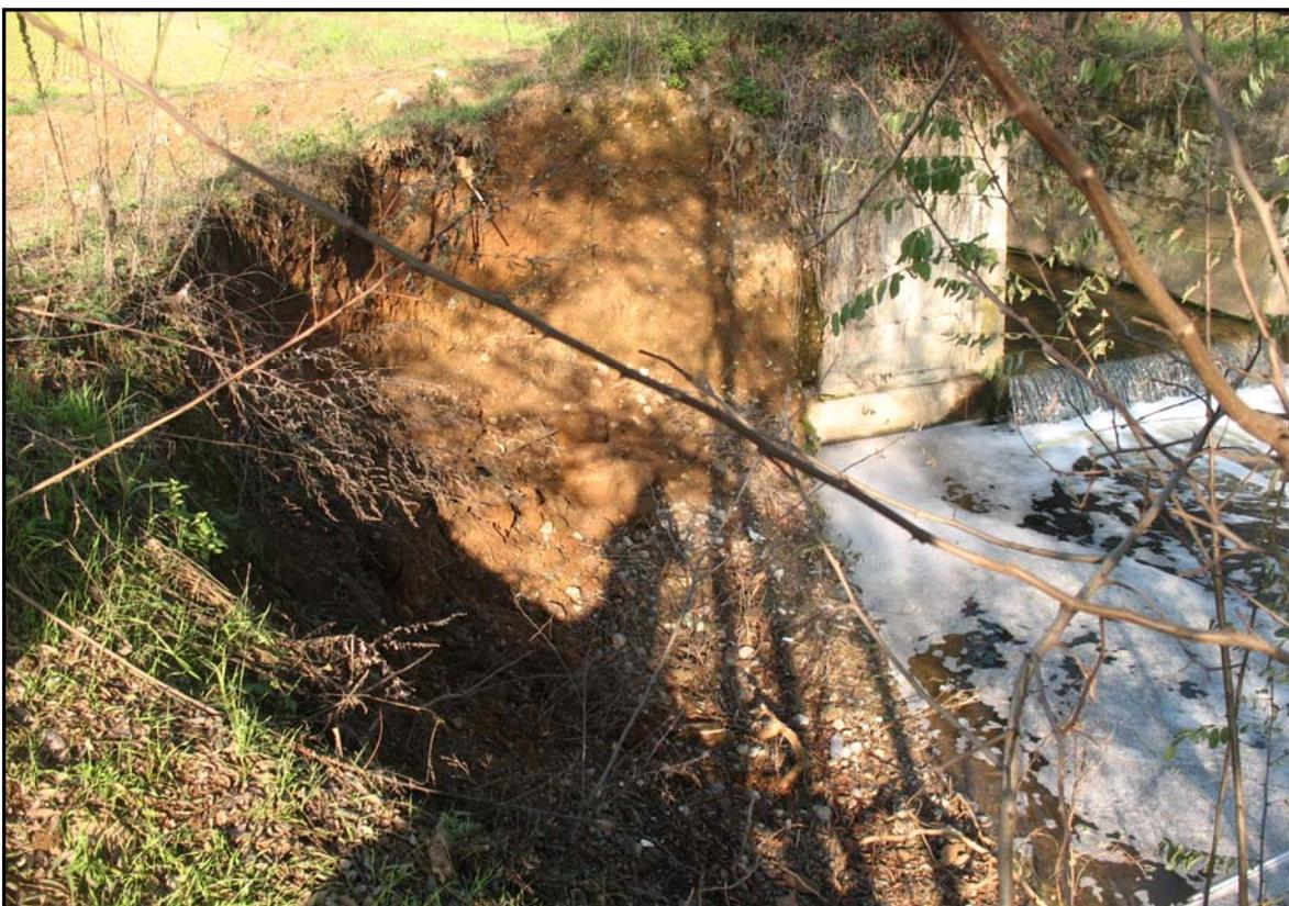
**Foto n. 3:** erosione della sponda destra, allo sbocco della canalizzazione artificiale
