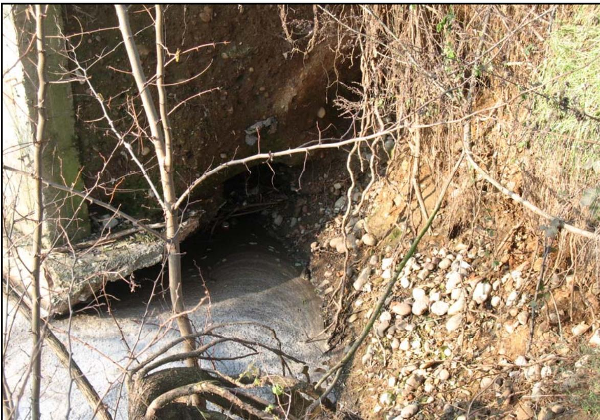
**Foto n. 2:** erosione della sponda sinistra, a valle della sezione n. 15, allo sbocco della canalizzazione
